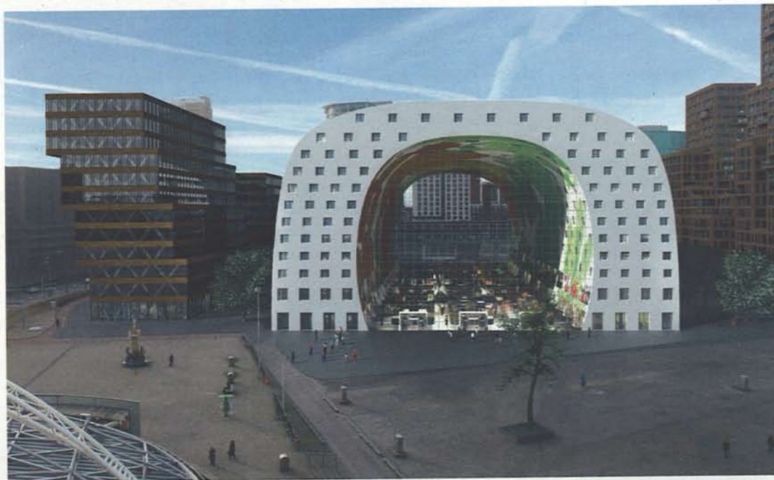
• Boogconstructie in tunnelbouw uitgevoerd.
