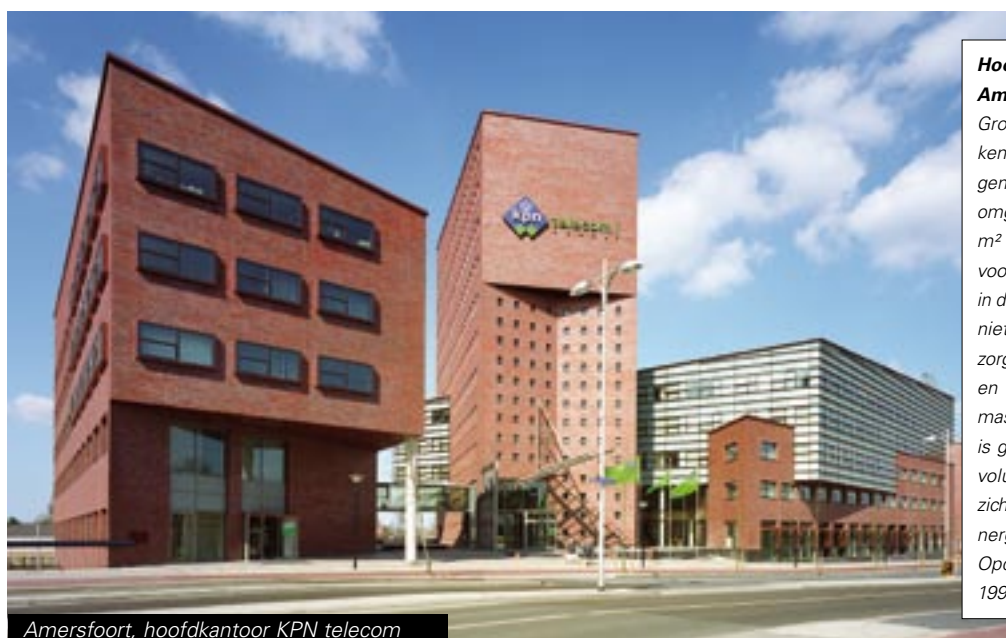
Amersfoort, hoofdkantoor KPN telecom
